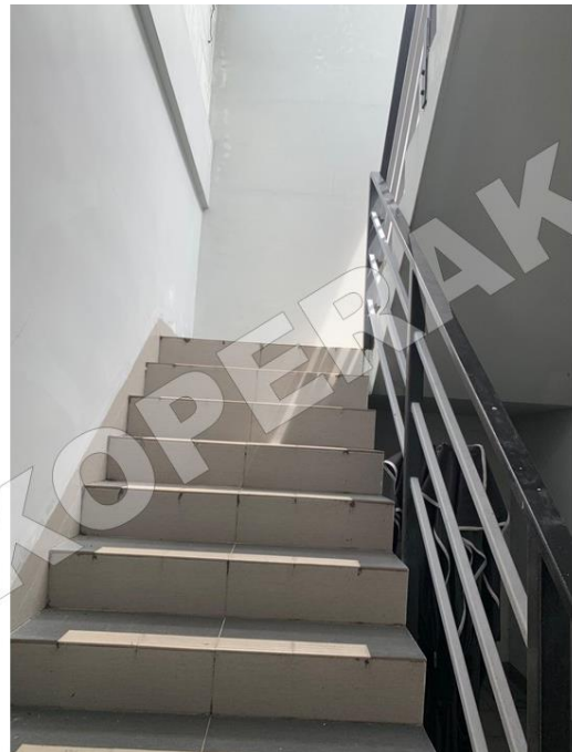
LALUAN KE RUANGAN SEWA
